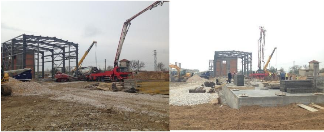
Estado de la obra civil 1ª Fase (Marzo 2014) Karlovo Biomass en Stroevvo (Bulgaria)
