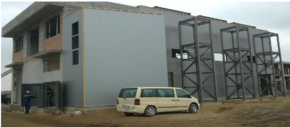
Estado actual obra civil 1ª Fase (Junio 2014) Karlovo Biomass en Stroevvo (Bulgaria)
