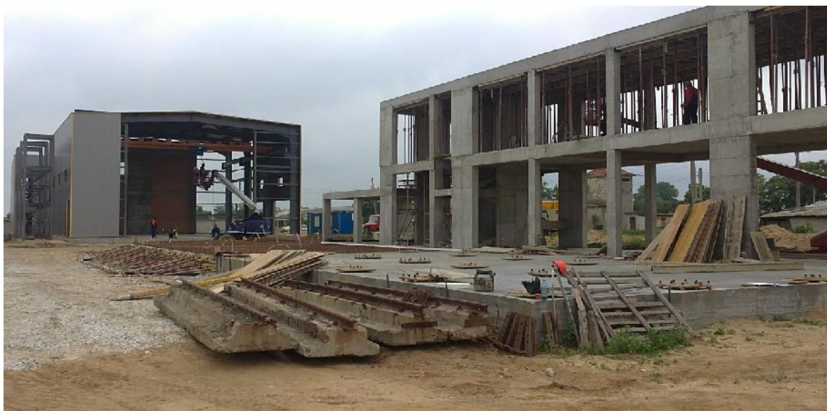
Estado actual obra civil 1ª Fase (Junio 2014) Karlovo Biomass en Stroevvo (Bulgaria)
