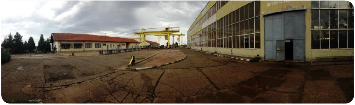
Instalaciones de ENERGOTEC ECO AD en Kaloyanovets, Stara Zagora (Bulgaria)
